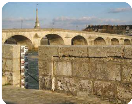
Parapet des quais de la Loire à Blois © C. Le Doussal
